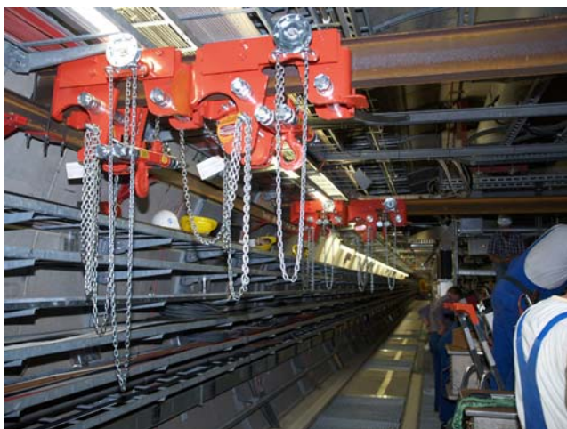
Abbildung 137: Hebe- und Verschiebevorrichtung für die BU-Spulenmontage im HERA-Ring.
